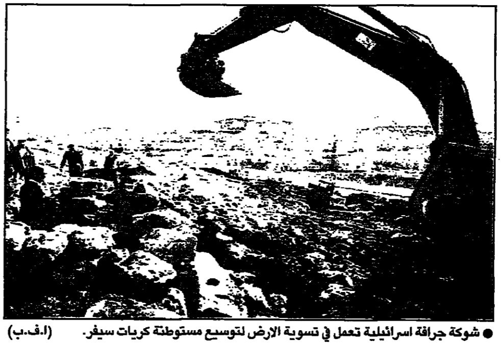
شوكة جرافة اسرائيلية تعمل في تسوية الارض لتوسع مستوطنة كريات سيفير. (ا.ف.ب)
